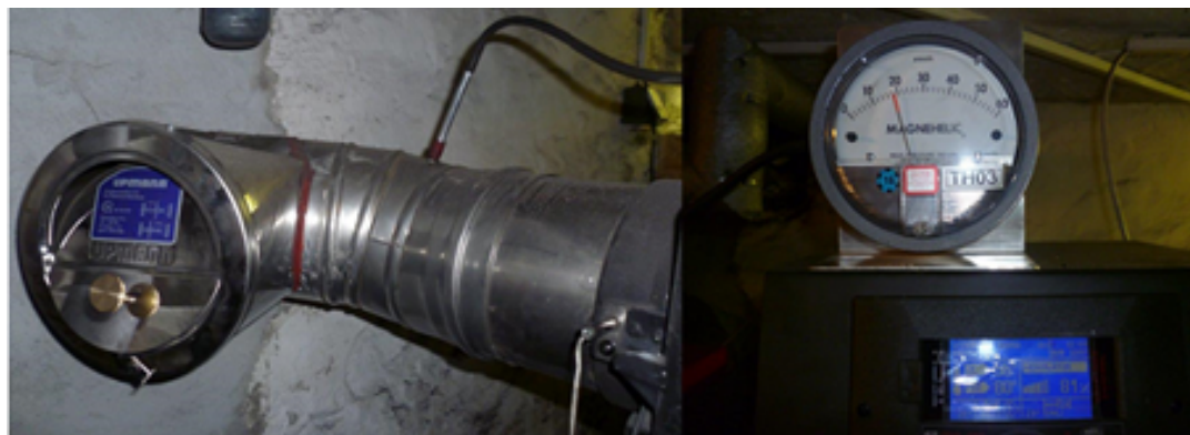
Obr. Měření komínového tahu
